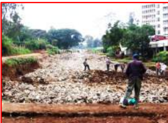
^ LA STRADA IN COSTRUZIONE
