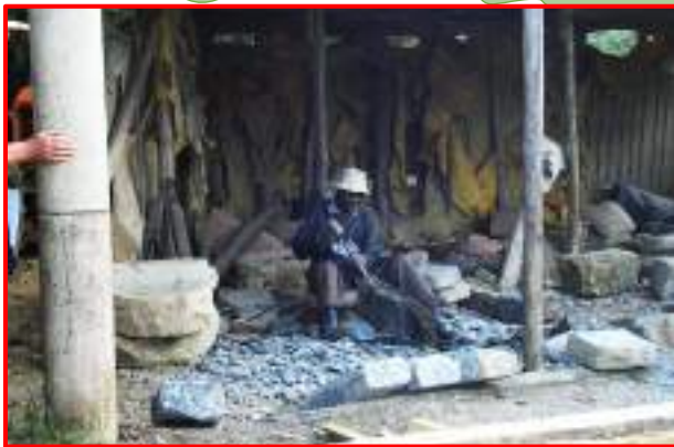
^ LA FABBRICA DELLA GHIAIA
