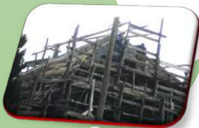
LA CATTEDRALE IN COSTRUZIONE
